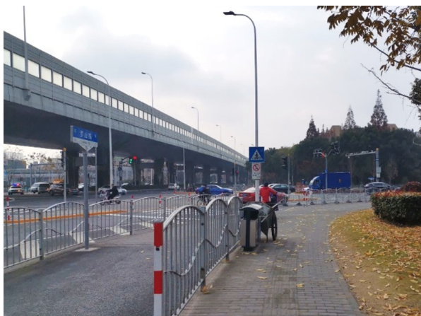
图6 宽马路的巨型交叉口，过街距离长且交通组织混乱
