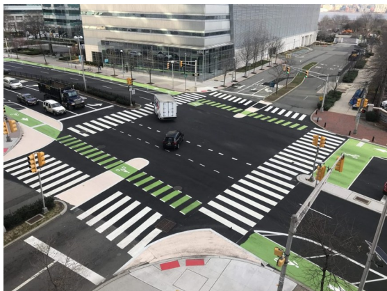
图 14 转弯半径过大的交叉口通过喷涂缩小转弯半径 (来源: STREETPLANS)
